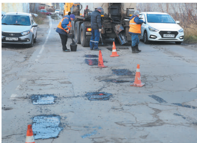
На улице Пожарского рабочие залатали больше 100 кв. м ям. Через 15–20 минут можно ездить по отремонтированному участку
