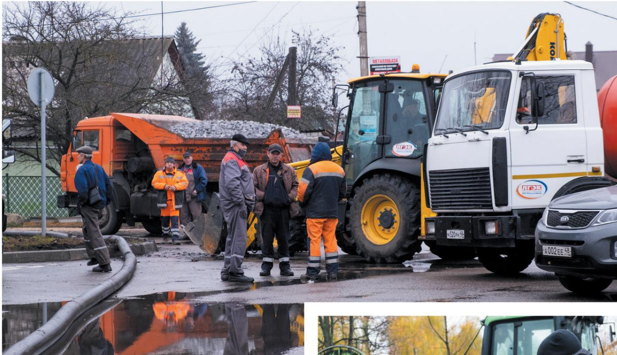
главный инженер АО «ЛГЭК» Дмитрий Будюкин. — Так как трубопровод пролегает под дорогой с интенсивным движением, было принято решение вывести аварийный участок из эксплуатации и проложить порядка 80 метров новой обводной трубы.
